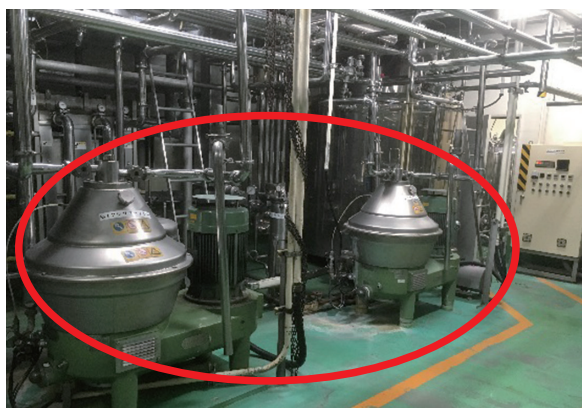
遠心分離機インバーター更新（第2プラント）
