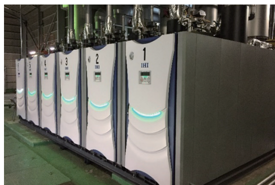
LNG 高効率ボイラー設置
