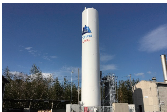
LNG サテライト設置
