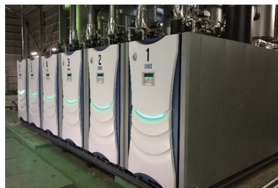
LNG 高効率ボイラー設置
