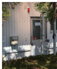
和歌山プラント 生体認証設備
