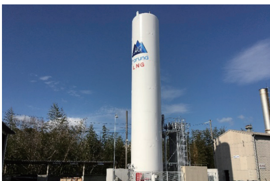
LNG サテライト設置
