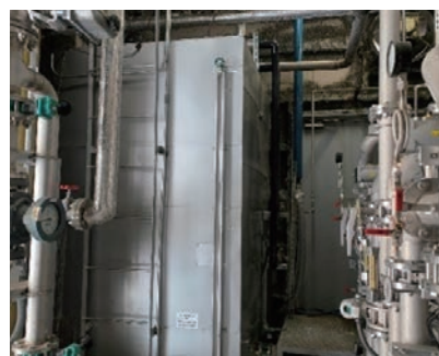
ボイラー軟水タンク バックアップ井水の節水 (ハルナプラント)
