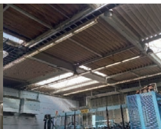
出荷設備周辺照明 LED 化 (タニガワプラント)
