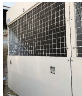
冷凍機の外観（ハルナプラント）
