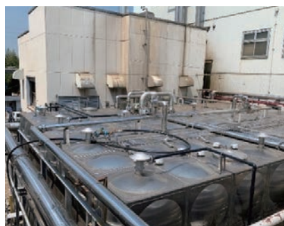
受水槽 工場排水の回収と再利用 (ハルナプラント)
