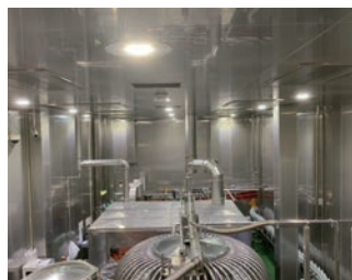
工場内室照明更新 (タニガワプラント)
